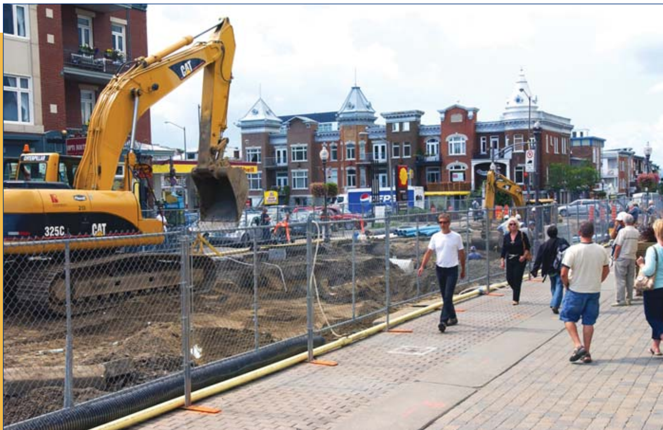
Travaux extérieurs de longue durée, clôture
