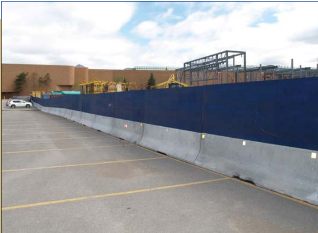
Travaux extérieurs de longue durée, palissade
