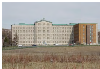
L'ancienne école La Jemmerais, qui abrite aujourd'hui le Centre de santé et de services sociaux de Québec-Nord. Un édifice érigé en deux temps (1928 et 1950). 2400, rue D'Estimauville. IMG_4295.jpg
