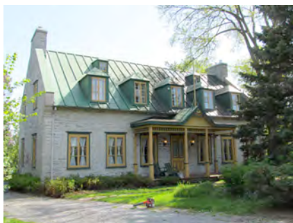
La maison Gore, érigée entre 1790 et 1822. 8, avenue des Cascades. IMG_1260.jpg
