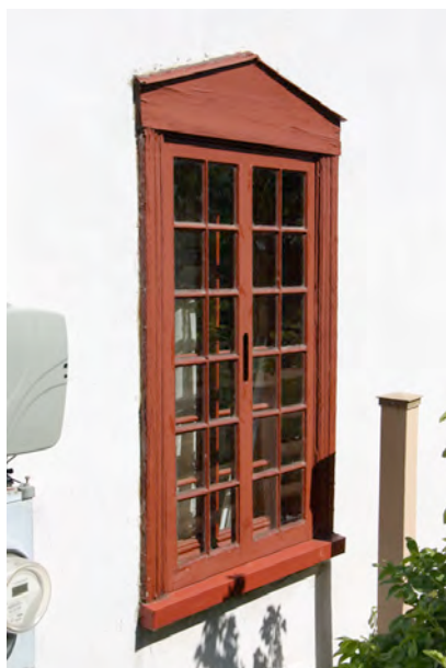
Fenêtre à battants à 24 petits carreaux et sa contre-fenêtre, caractéristique des bâtiments du 18 e siècle. 412, avenue Sainte-Thérèse. IMG_9782.jpg
