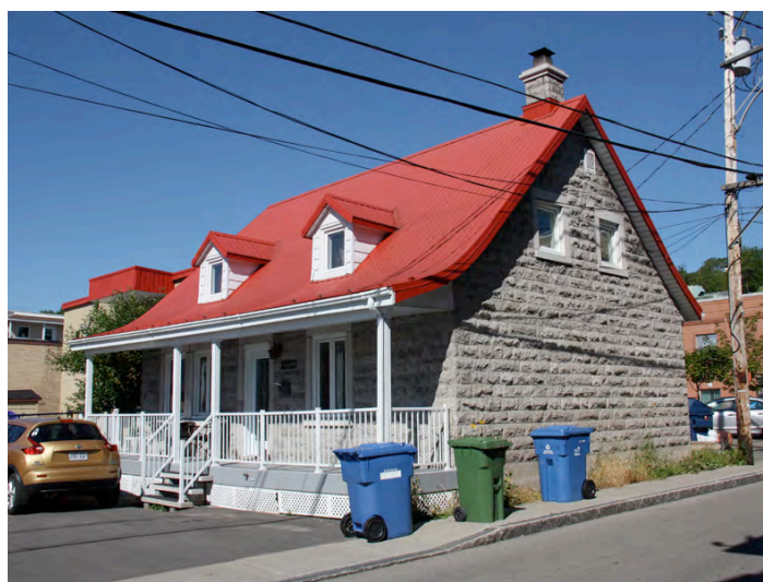
Le 50, 103 e Rue aujourd'hui. Un revêtement de pierre a été mis en place en 1982. À cela s'ajoutent la modification des fenêtres (modèle, disposition) et la disparition du garde-corps en bois et des garnitures de rive. IMG_9262.jpg
