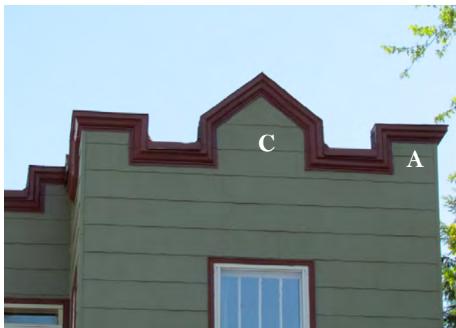
Corniche décorative au sommet de l'avant-corps d'une maison de faubourg à toit plat: des amortissements (A) aux extrémités et un couronnement en mitre (C) au centre. 1986-1988, avenue du Monument. IMG_0948.jpg
