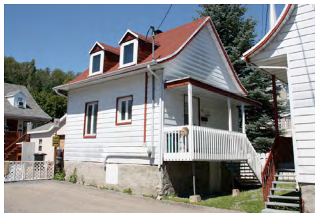
Le 17, 102 e Rue aujourd'hui. Les fenêtres à battants à grands carreaux sont disparues, tout comme le revêtement de planche à feuillure, les garnitures de rive et le garde-corps à barreaux en bois. IMG_9442.jpg
