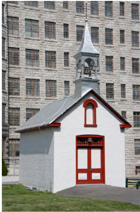
Chapelle de l'ancienne paroisse Saint-Michel-Archange. IMG_8823.jpg
