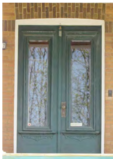
Porte à doubles battants avec petite corniche au bas des fenêtres, typique des résidences du premier tiers du 20 e siècle. 2317, rue de la Terrasse-Cadieux. IMG_0010.jpg
