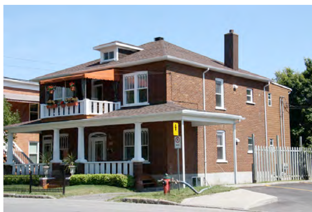
Exemple de maison cubique (Four Square Style). 3364-3366, chemin Royal. IMG_9218.jpg
