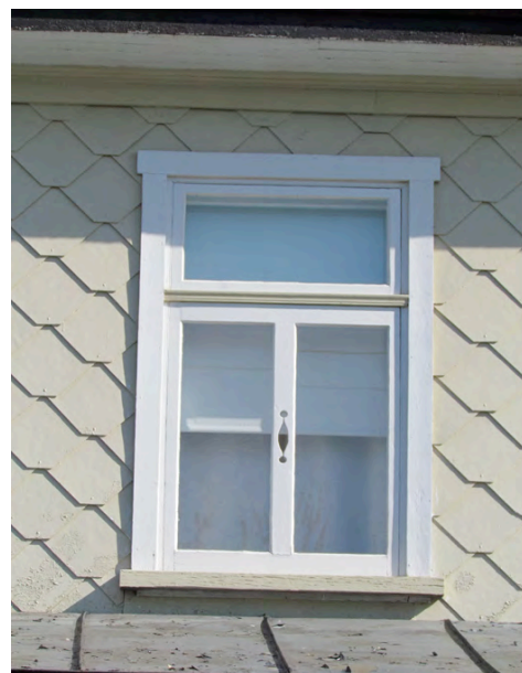
Fenêtre à battants à imposte au 515-519, avenue Joseph-Giffard, typique des résidences du premier tiers du 20 e siècle. IMG_0216.jpg
