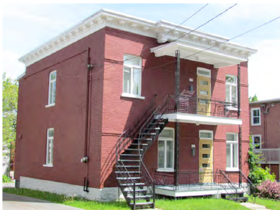
Exemple de plex. 79-81, rue du Manège. IMG_2095.jpg
