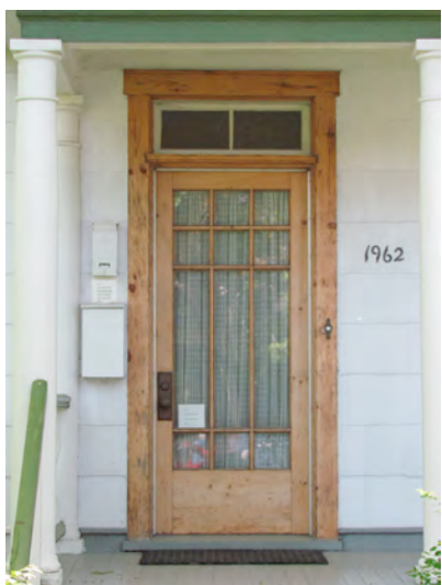
Porte en menuiserie d'assemblage surmontée d'une imposte, cette étroite baie rectangulaire à deux carreaux. 1962, avenue du Monument. IMG_0918.jpg
