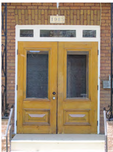
Porte à doubles vantaux, avec imposte à trois carreaux. 1985, avenue du Monument. IMG_0940.jpg
