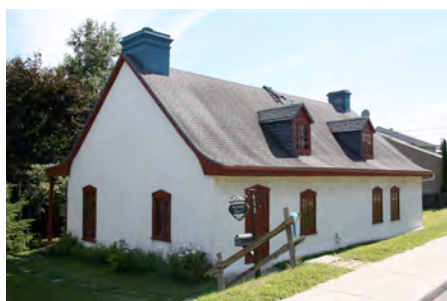
La maison Pascal érigée vers 1720, soit le plus ancien édifice étudié. 412, avenue Sainte-Thérèse. IMG_9776.jpg
