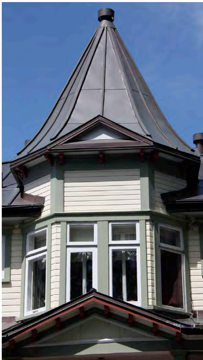
Toit polygonal surmontant la logette à trois pans en façade avant du 172, rue Odette-Pinard. IMG_9688.jpg
