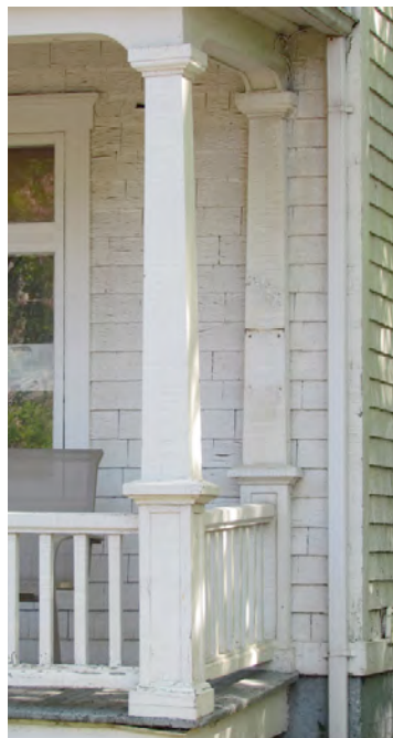
Colonne carrée en bois, avec un socle à sa base et un chapiteau à son sommet. Une composante qui devient de plus en plus rare à Beauport. 1985, avenue du Monument.
