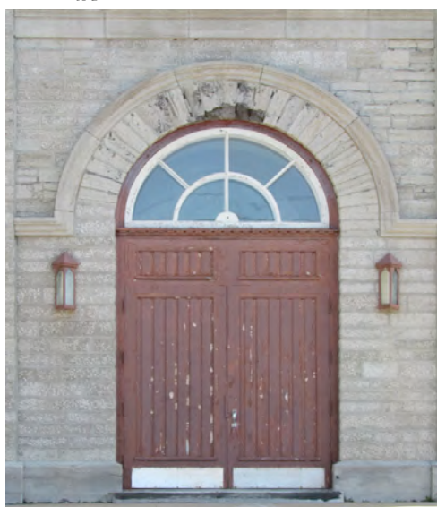
Porte à doubles battants de l'ancienne église Saint-Grégoire, surmontée d'une imposte à arc plein cintre à petits-bois radiants. Un arc plein cintre en pierre de taille surplombe l'ensemble. IMG_0057.jpg
