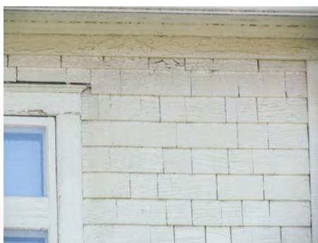
Détail du revêtement de bardeau de bois très bien préservé au 1980, avenue du Monument. IMG_0933.jpg
