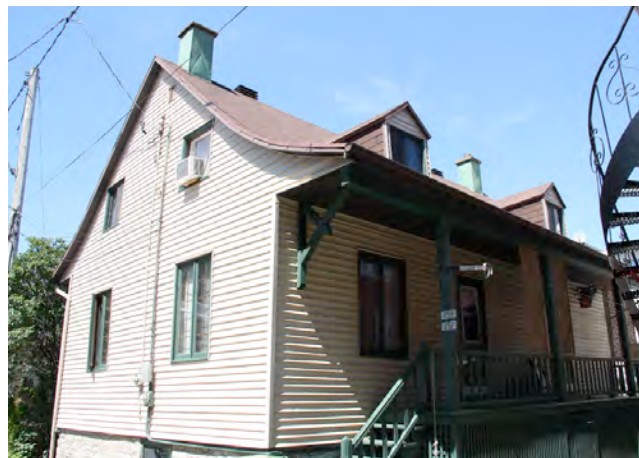
Le 257-259, 108 e Rue aujourd'hui. Les fenêtres à battants à grands carreaux, le revêtement de planche à clin et les garnitures de rive sont disparus. IMG_9455.jpg
