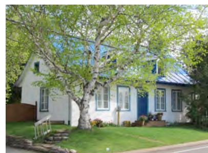
La maison Pierre-Antoine-Chalifour, érigée vers 1780, un immeuble patrimonial classé. 415, avenue Sainte-Thérèse. IMG_0398.jpg
