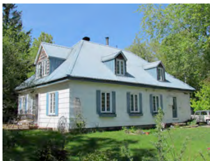
La villa Mon-Repos, dont la construction remonterait aux environs de 1825, ce qui en ferait l'un des plus anciens édifices inventoriés dans le quartier Giffard. 3945-3947, rue Chabanel. IMG_1252.jpg
