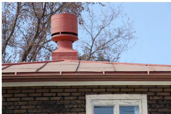
La tôle pincée est notamment en usage sur certains bâtiments secondaires, comme celui-ci situé au 2400, avenue D'Estimauville. IMG_9580.jpg
