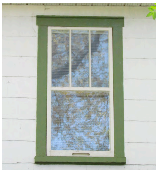
Fenêtre à guillotine à petits-bois, fréquente sur les édifices de la période 1910-1940. 1962, avenue du Monument. IMG_0915.jpg
