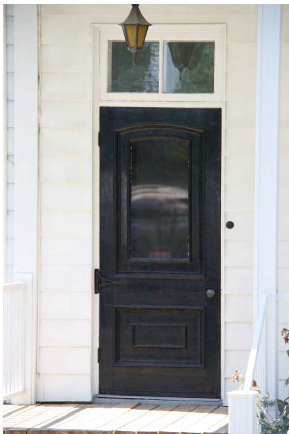
Porte à moulures appliquées et à vitrage en arc surbaissé, surmontée d'une imposte à carreaux. 2497, chemin de la Canardière. IMG_9103.jpg
