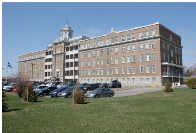
Exemple d'édifice de style Beaux-arts. 2915, avenue du Bourg-Royal. IMG_4337.jpg
