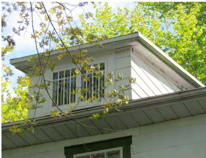
Lucarne en appentis avec fenêtre double, dont le toit est à un seul versant, une composante typique des édifices de la première moitié du 19 e siècle. 1962, avenue du Monument. IMG_0917.jpg
