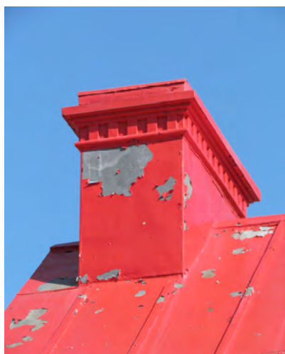
Imposante souche de cheminée, mise en valeur par un bandeau et une corniche à consoles. Maison Binet-Lortie, 535, avenue Joseph-Giffard. IMG_0240.jpg
