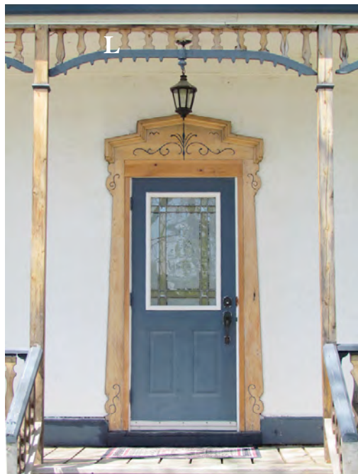
Lambrequins à fuseaux tournés (L) en bordure du toit de la galerie du 381-383, avenue Joseph-Giffard. IMG_0161.jpg
