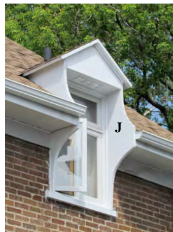
Autre modèle de lucarne à fenêtre pendante sur un édifice au toit à deux versants droits. Les joues (J), prolongées en longues consoles, cachent les coupes de l'avant-toit. 51, avenue du Collège. IMG_1976.jpg
