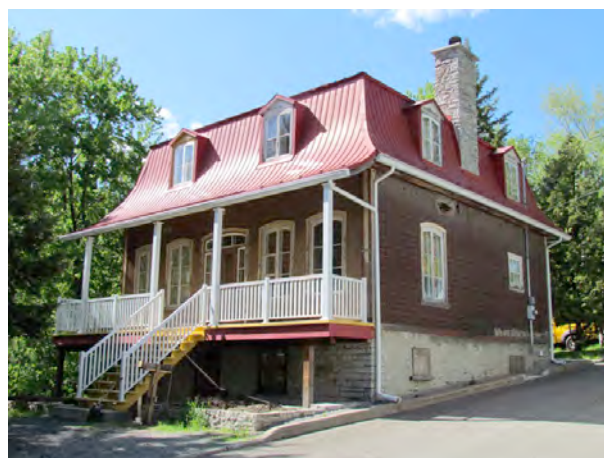
Exemple de maison à mansarde, au brisis sur quatre côtés. 2385, avenue du Vieux-Moulin. IMG_1093.jpg
