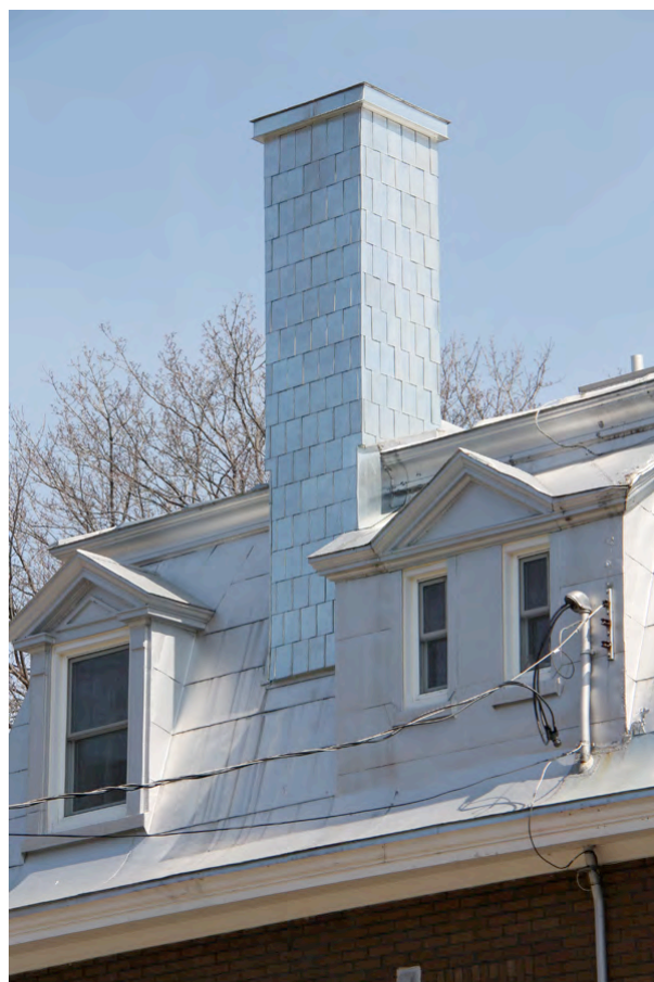
Tôle en plaques sur le brisis du 3381, avenue Saint-Rédempteur. IMG_4191.jpg
