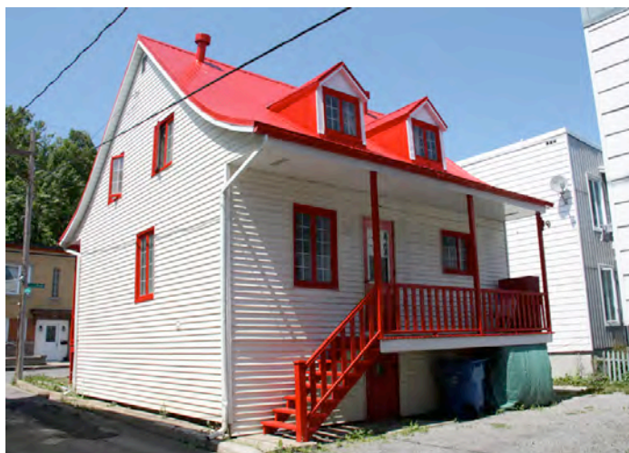
Le 111, avenue Ruel aujourd'hui. Les fenêtres à battants à grands carreaux, le revêtement de planche à feuillure et les garnitures de rive ont été supprimés. En outre, le format d'au moins une fenêtre a été modifié. IMG_8491.jpg
