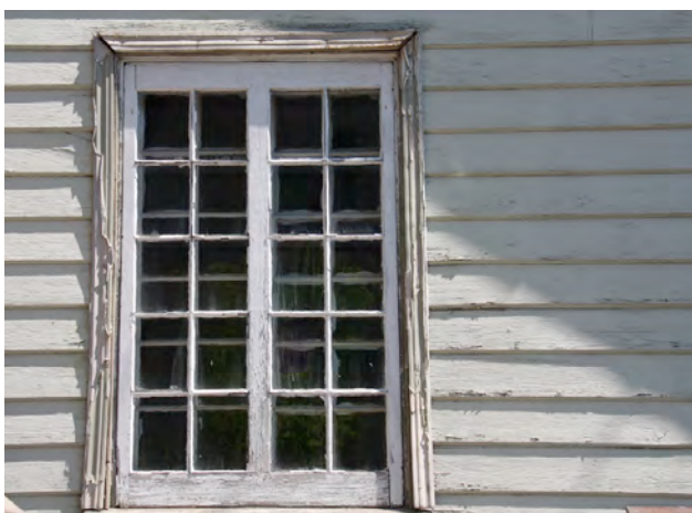
La planche à clin que l'on retrouve ici sur l'un des plus vieux édifices du quartier Montmorency, l'ancienne maison d'employés de la scierie Patterson. 19-20, avenue Saint-Grégoire IMG_8431.jpg
