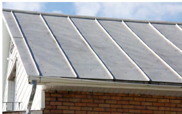
Revêtement de tôle pincée au 46-48 1/2 , côte de Courville, érigé vers 1920. IMG_9580.jpg
