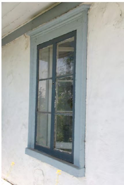
La garniture de fenêtre «classique», composée de chambranles (montants verticaux), d'une corniche et d'un appui (aussi appelé tablette). 43-46, avenue Saint-Grégoire.
