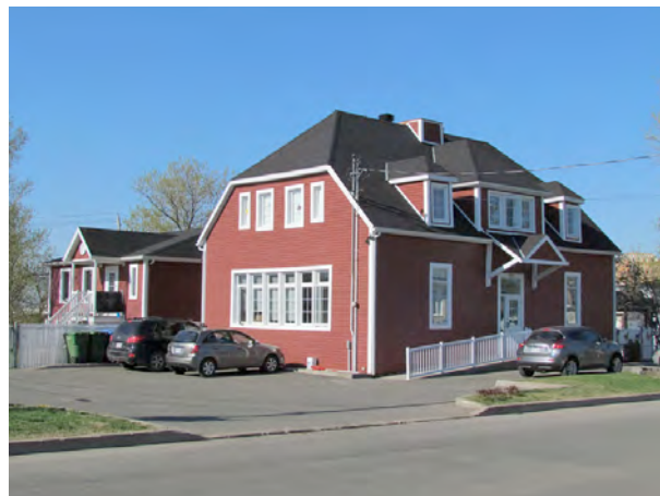
Exemple d'édifice Arts and Crafts. École du rang Saint-Joseph au 450, avenue Joseph-Giffard. IMG_0209.jpg
