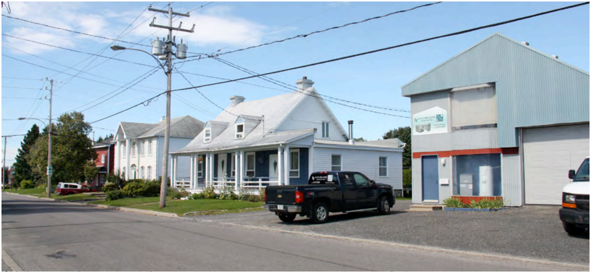
Edifices modernes encadrant très mal le 243, avenue Saint-Michel. IMG_0614.jpg
