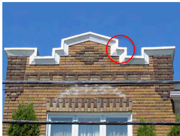
Autre type de corniche de bois, sur mur de brique cette fois, ornée d'amortissements et d'un couronnement en mitre à ressauts (le cercle indique l'un des ressauts). 2172-2176, avenue du Vieux-Moulin. IMG_1068.jpg
