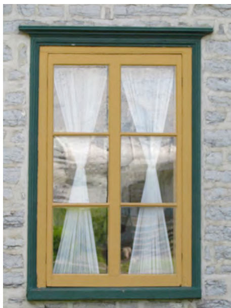
Fenêtre à battants à six grands carreaux, principalement en usage entre le milieu du 19 e siècle et le premier quart du 20 e siècle. Maison Gore, 8, avenue des Cascades. IMG_1263.jpg
