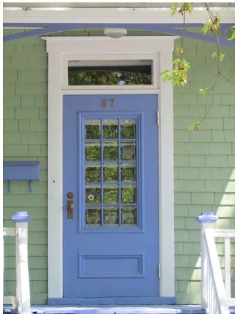
Chambranle et corniche simples encadrant la porte principale du 97, avenue du Collège. Une autre garniture de porte «classique».
