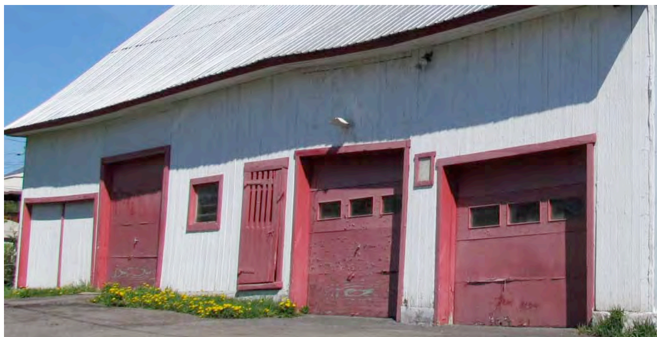
Détail du revêtement de planche unie en façade avant d'une grange-étable au 80, rue de la Chicorée. IMG_0670.jpg
