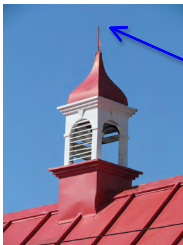
Très beau lanternon de ventilation, couvert d'un petit toit à l'impérial, au sommet d'un bâtiment secondaire. 535, avenue Joseph-Giffard. IMG_0036.jpg
