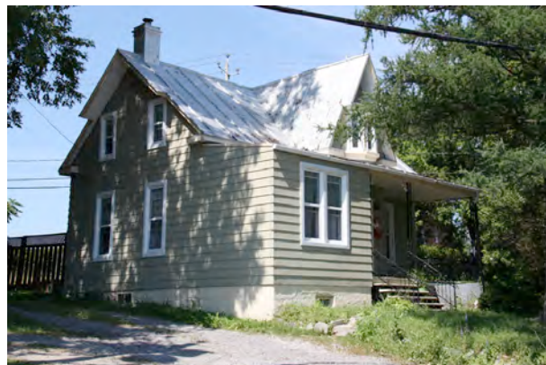
Exemple d'édifice de style néogothique. 2625, chemin du Petit-Village. IMG_9107.jpg
