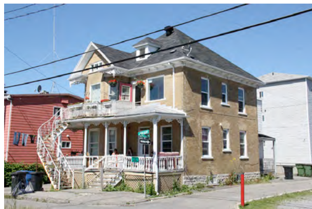
Exemple d'édifice de style néo-Queen Anne. 270-274, 107 e Rue. IMG_9314.jpg
