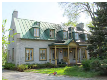
Maison Gore, 8, avenue des Cascades, un immeuble patrimonial classé. IMG_1260.jpg
