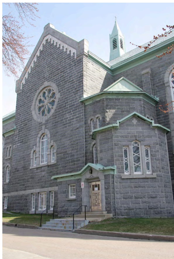
Transept de l'église Saint-Ignace-de-Loyola, 3325, avenue Loyola. IMG_4130.jpg
