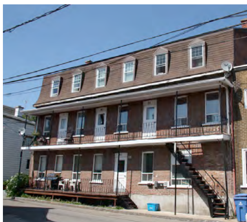
Le 31-37, 103 e Rue aujourd'hui. Le garde-corps découpé à jour a été remplacé par un garde-corps en fer ornemental. Les fenêtres à battants à grands carreaux sont disparues. IMG_8578.jpg
