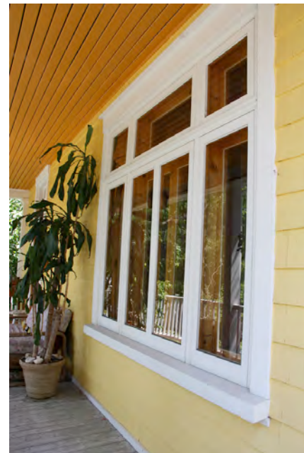
Appui saillant et large chambranle encadrant l'une des fenêtres du 34, rue Saint-Edmond. IMG_9063.jpg
