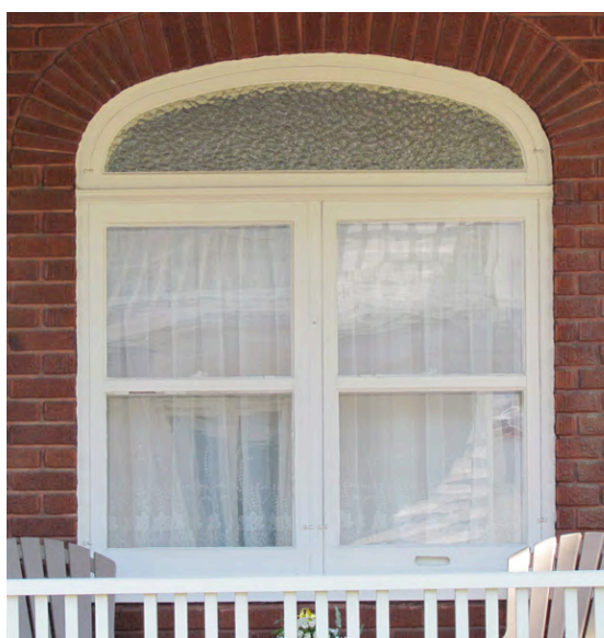
Fenêtres à guillotine jumelées avec imposte en anse de panier. 2024, avenue du Monument. IMG_0957.jpg
