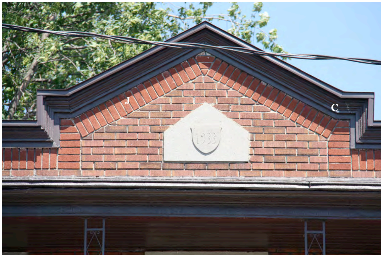
Couronnement ou fronton avec corniche (C), jeu de brique (J) et pierre de date. 3391-3395, chemin Royal. IMG_8983.jpg
