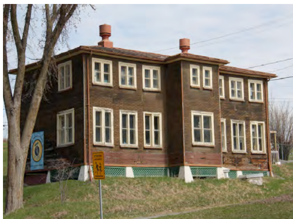
Bâtiment secondaire de l'école Lajemmerais servant à des fins d'entreposage. En 1954, il est utilisé comme atelier. 2400, avenue D'Estimauville. IMG_4327.jpg
