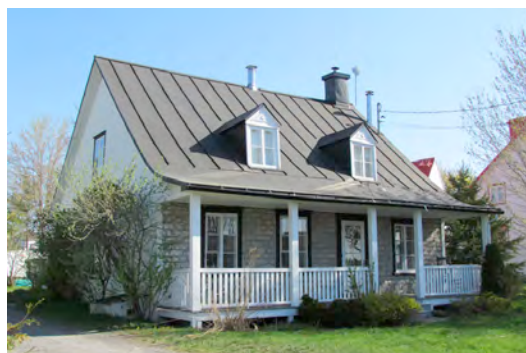
Le 531, avenue Joseph-Giffard aujourd'hui. Le revêtement de pierre a été mis au jour et on a mis en place un garde-corps à barreaux. IMG_0218.jpg
