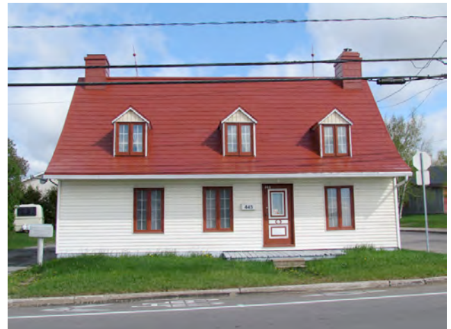
Le 443, avenue Sainte-Thérèse aujourd'hui. Les fenêtres à battants à grands carreaux sont disparues, tout comme le revêtement ancien et les garnitures de rive. La porte a néanmoins été préservée. IMG_0414.jpg
