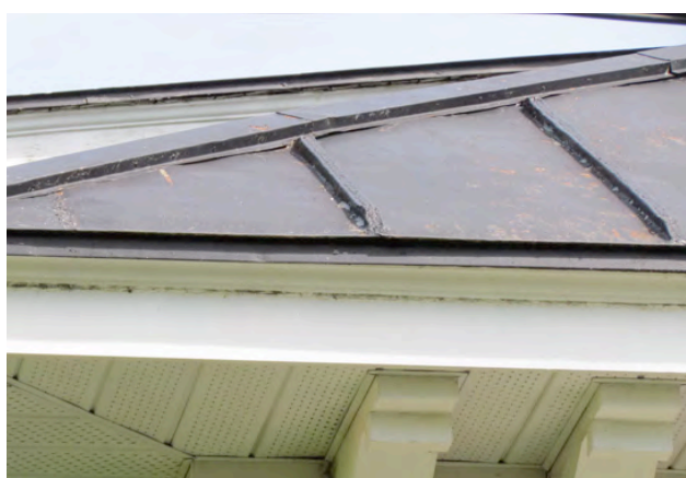
Tôle à baguettes au 21-23, avenue du Collège, un édifice datant du début des années 1920. IMG_1942.jpg
