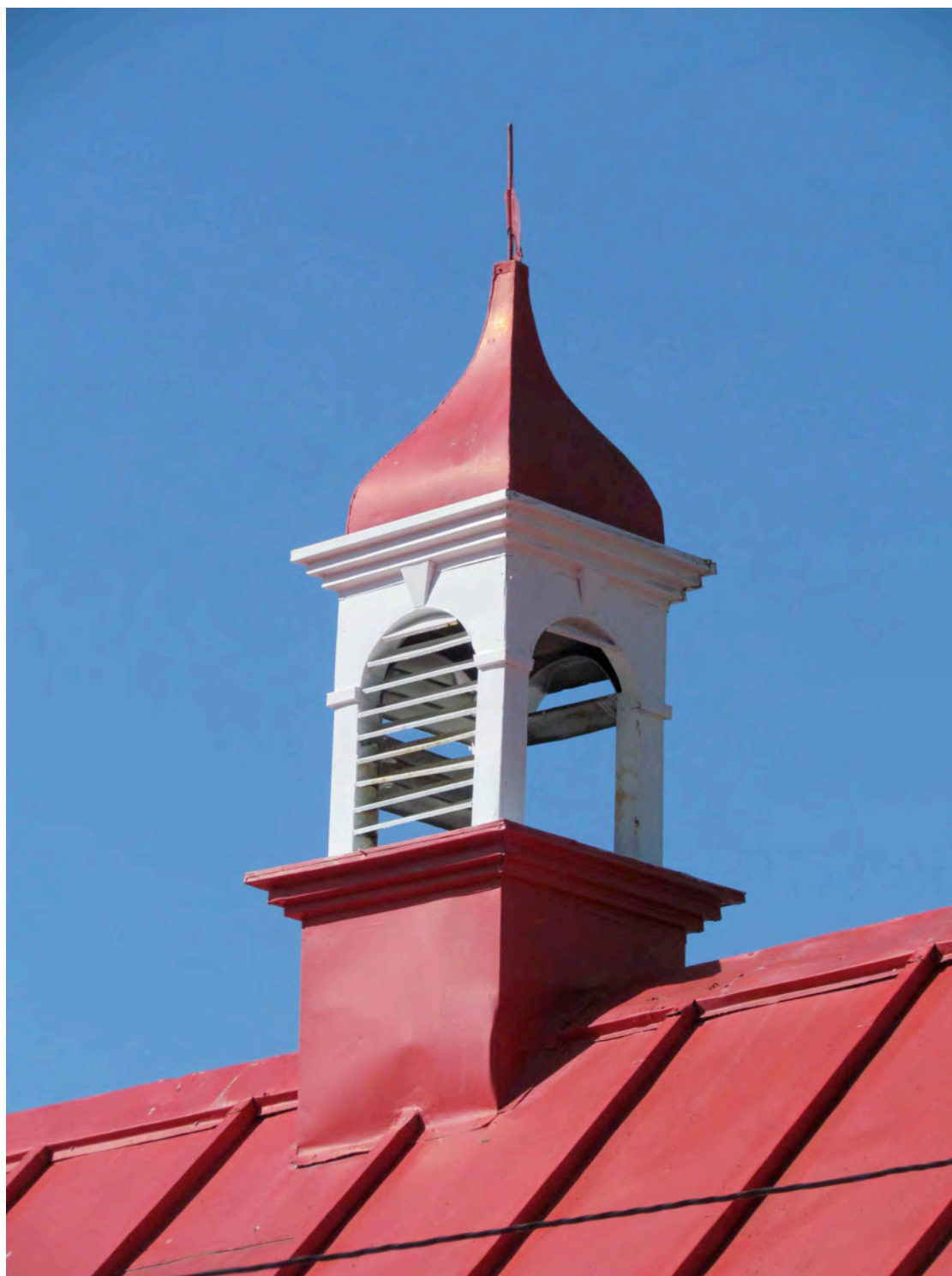
Lanternon de ventilation du bâtiment secondaire du 535, avenue Joseph-Giffard. IMG_0243.jpg
