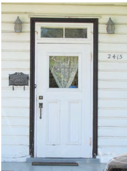
Porte en menuiserie d'assemblage à panneaux, surmontée d'une imposte. 2415-2421, avenue Saint-Clément. IMG_1018.jpg
