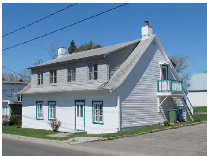
Le 181-183, avenue Saint-Michel, vraisemblablement érigé au premier tiers du 19 e siècle. La répartition asymétrique des ouvertures en façade avant laisse supposer que l'édifice a été agrandi au fil du temps.
