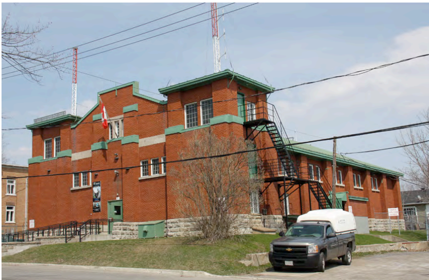
Manège militaire de Beauport érigé en 1914. 101, rue du Manège. IMG_4266.jpg
