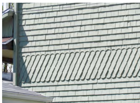
Exemple de revêtement de bardeau de bois découpé, un parement mural de plus en plus rare. 961-963, boulevard des Chutes. IMG_0723.jpg
