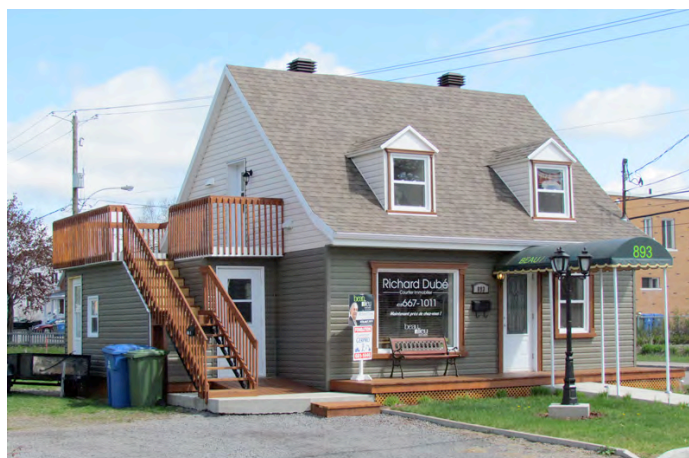
Le 803, avenue Sainte-Thérèse (ancienne école du rang Sainte-Thérèse) aujourd'hui. La fenestration a complètement été changée en façade avant. IMG_0480.jpg
