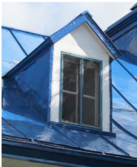
Lucarne à pignon « classique », le modèle le plus usuel sur la maison associée à l'architecture de la maison néoclassique québécoise. Maison Pierre-Antoine-Chalifour, 415, avenue Sainte-Thérèse. IMG_0402.jpg
