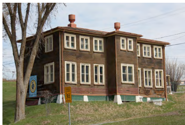
Bâtiment secondaire unique en son genre à Beauport, rattaché au 2400, avenue D'Estimauville. IMG_4327.jpg
