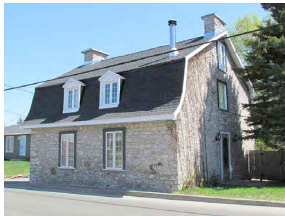
Le 252, avenue Saint-Michel aujourd'hui. Les fenêtres à battants à grands carreaux sont remplacées par un modèle moderne et une ouverture a été ajoutée sur le mur pignon. IMG_0344.jpg
