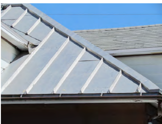
Revêtement de tôle à baguettes au 1930-1936, avenue Poulin. Il est intéressant de constater l'usage plutôt tardif de ce matériau sur cet édifice dont l'architecture est associée aux premiers bungalows. IMG_0962.jpg
