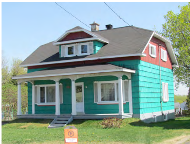
Exemple d'édifice Arts and Crafts. 108, avenue Saint-Michel. IMG_0373.jpg
