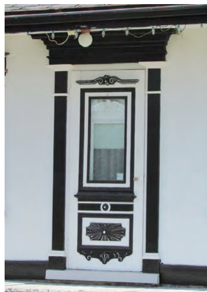
Porte à panneaux, ornée d'appliques sculptées en plus des pilastres et de la corniche du chambranle. Le 269, rue Lafèche érigé au milieu du 19 e siècle. IMG_0134.jpg
