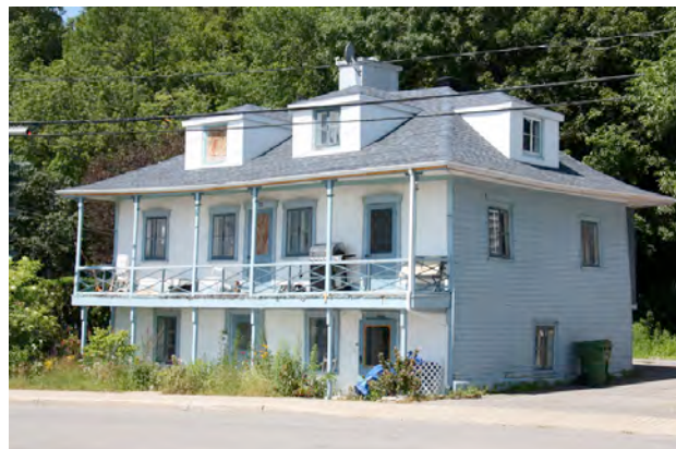
Exemple de cottage de style Régence. 43-46, avenue Saint-Grégoire. IMG_8384.jpg
