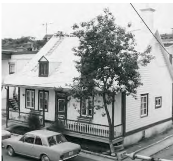
Le 50, 103 e Rue en 1969. L'édifice est alors revêtu de planche à feuillure; il possède encore ses fenêtres à battants à grands carreaux et son garde-corps à barreaux. M.A.C., Inventaire monumental , 1969 103e Rue 50-3.jpg
