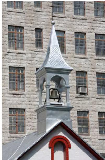
Clocher recouvert de tôle en plaque de la chapelle, récemment restauré. IMG_8823.jpg
