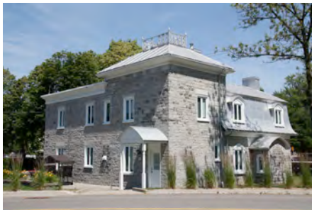
Le 2183, chemin de la Canardière, un édifice en pierre à toit mansardé, la plus ancienne des résidences d'employés. IMG_9072.jpg
