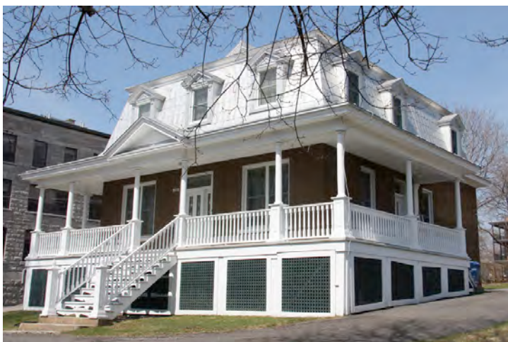
Le 3381, rue Guimont, un édifice en brique à toit mansardé. Il s'agit de l'ancien presbytère des aumôniers de sœurs de Sainte-Chrétienne érigé en 1927 IMG_4177.jpg
