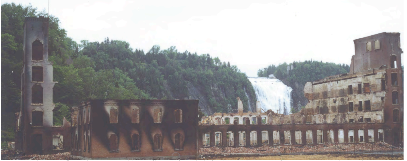
La Dominion Textile Co. juste après l'incendie qui détruit le bâtiment le 15 octobre 1991. Les ruines à l'avant-plan sont celles du bâtiment qui était utilisé comme bureau administratif par les dirigeants anglophones de la compagnie. SAHB, collection Georges Lortie P4273. Dominion Texte inc. - P4273 Georges Lortie.jpg
