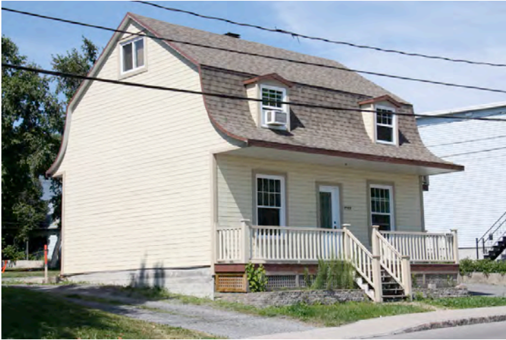
Le 2421-2423, chemin du Petit-Village, érigé vers la fin du 19 e siècle, l'un des plus anciens édifices du secteur. IMG_9121.jpg
