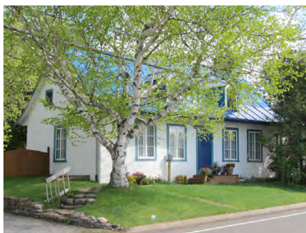
La maison Chalifour, 415, avenue Sainte-Thérèse. Imposant édifice construit vers 1780 et le second plus ancien de l'avenue Sainte-Thérèse, c'est un immeuble patrimonial classé. IMG_0398.jpg
