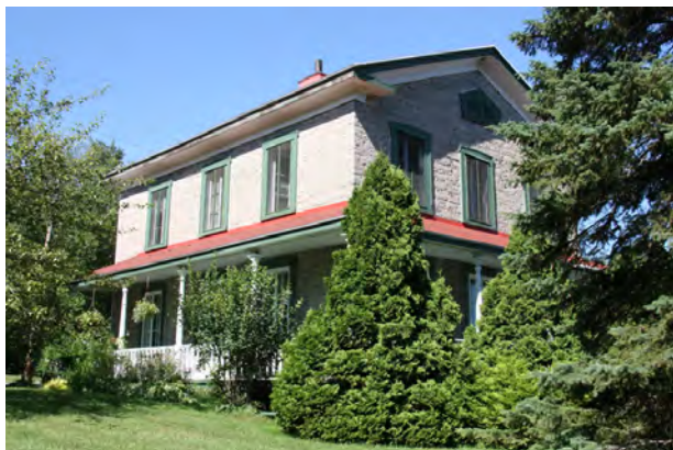
Le 63, côte Benson-Hall. IMG_9539.jpg
