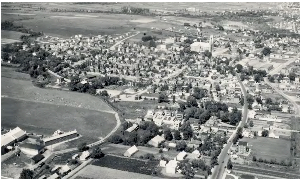
Le quartier Giffard en 1958. Les artères au nord de la rue Loyola se sont considérablement développées depuis la fin des années 1930. En bas à gauche se dresse une partie du site de la ferme SMA. SAHB. Fonds Roger Rainville. Giffard Vue aérienne 1958 P3614 -SAHB, Roger Rainville.jpg
