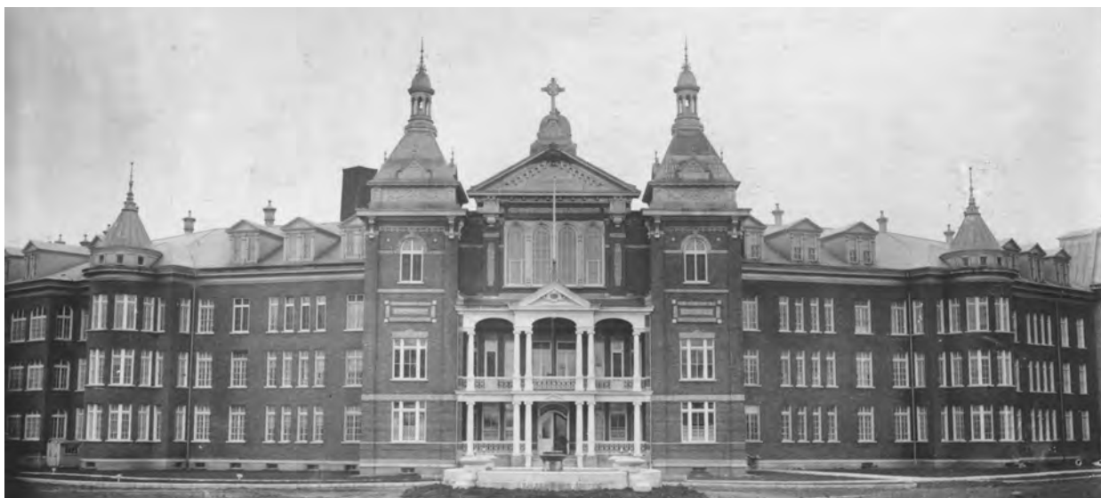
Section de l'administration de l'hôpital, photographiée ici en 1915, avec son avant-corps central doté de deux tours encadrant l'entrée principale. Musée Lucienne-Maheux.. Administration_Asile_aliénés_Québec MLM 1915 ca.jpg
