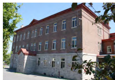
L'ancienne école Saint-Édouard, qui fait maintenant partie de l'école Monseigneur-Robert. IMG_9174.jpg
