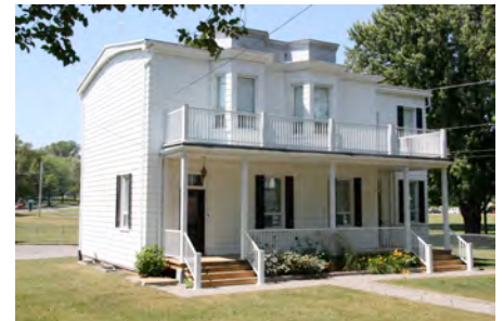
Le 2497, chemin de la Canardière, une maison de faubourg, à l'origine à toit plat, la troisième résidence d'employés. IMG_9097.jpg
