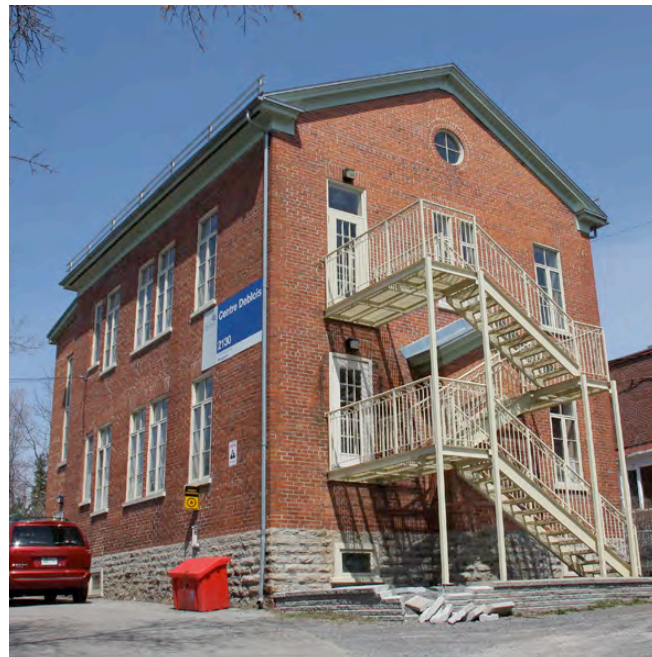
L'école Deblois aujourd'hui. Exception faite de la mise en place d'un escalier de secours, l'édifice présente une assez bonne intégrité architecturale. IMG_4215.jpg
