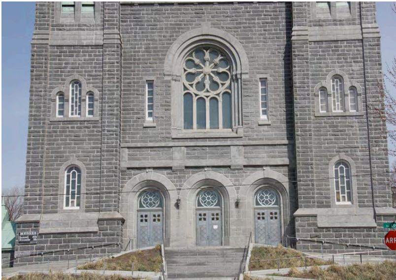
Détail de façade de l'église Saint-Ignace-de-Loyola. IMG_4124.jpg
