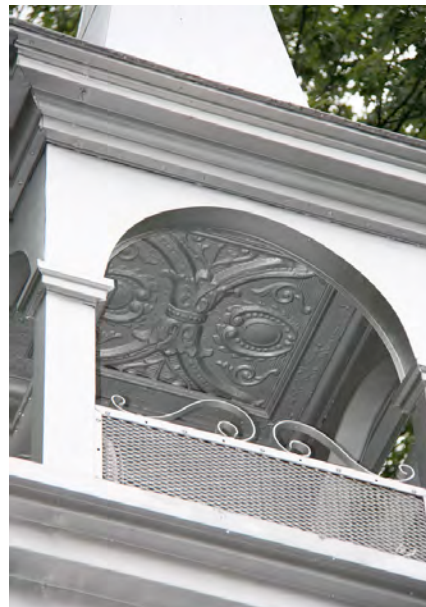
Intérieur du clocher de la chapelle du cimetière des Sœurs de la Charité de Québec, avec son revêtement intérieur de tôle de fins motifs embossés. IMG_9917.jpg
