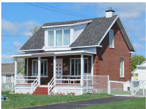
Le 861, avenue Sainte-Thérèse, l'un des édifices érigés vers 1930 dans le secteur Sainte-Thérèse. IMG_0458.jpg
