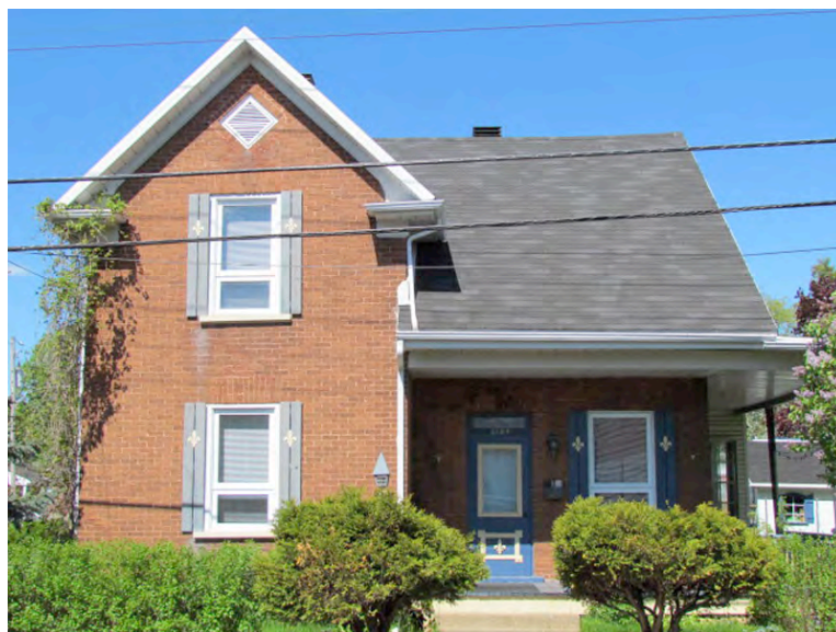
Le 2184, avenue du Vieux-Moulin, l'un des édifices de Giffard dont l'architecture est représentative du premier tiers du 20 e siècle. IMG_1072.jpg
