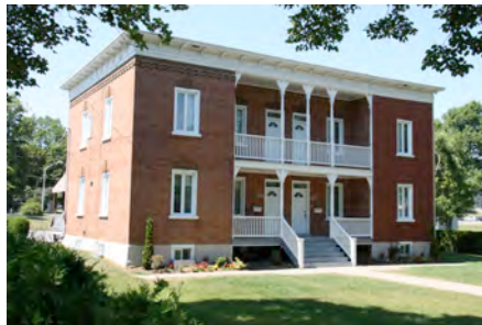
Le 2487-2489, chemin de la Canardière, un immeuble de type plex en brique structurale, la seconde résidence d'employés. IMG_9087.jpg
