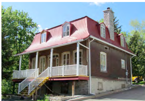
Le 2385, avenue du Vieux-Moulin, un édifice érigé vers les années 1850, mais probablement modifié sous sa forme actuelle au tournant du 20 e siècle.
