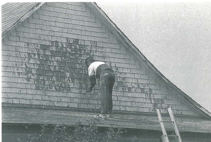
Une bonne préparation de la surface est essentielle si on veut éviter...
