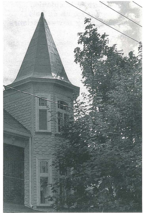
Cette tourelle d'une maison de la rue Fraser est recouverte de bardeaux décoratifs.
