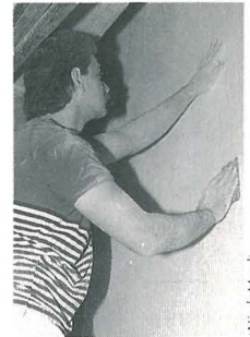
Ponçage des surfaces avant de repeindre.
