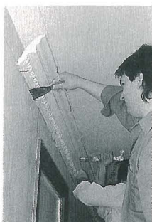
Installation d'une corniche moulée en plâtre.
