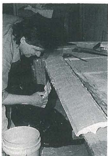
Installation d'une corniche moulée en plâtre.
