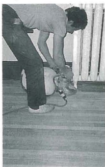
Sablage des coins au moyen d'une ponceuse à disque.
