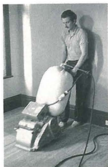
Sablage d'une grande surface de plancher à l'aide d'une ponceuse munie d'un tambour rotatif.
