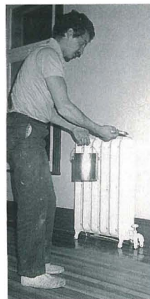
Application du vernis à l'aide d'un pinceau.
