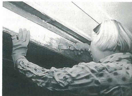
Décapage de boiseries à l'aide de décapant chimique.
