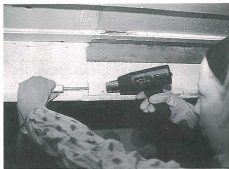
Décapage de boiserie au moyen d'un pistolet à air chaud.
