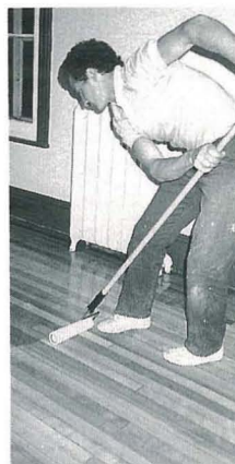
Application du vernis à l'aide d'un rouleau.
