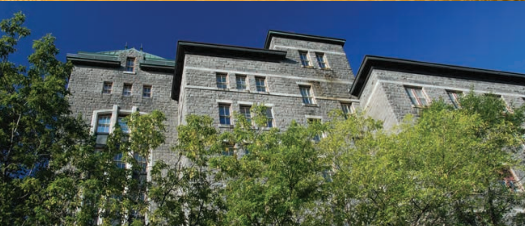
^ Le bâtiment principal de l'Institut universitaire en santé mentale de Québec.
