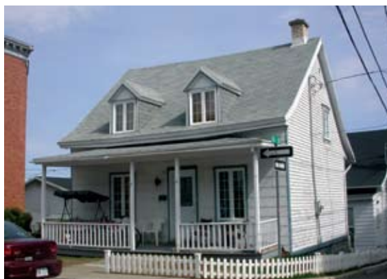
75, avenue Ruel. Avec son toit à deux versants percé de lucarnes et sa galerie couverte d'un avant-toit, cette maison en bois est typique des premières habitations de Montmorency. Photo: Les Alliés, 2010
