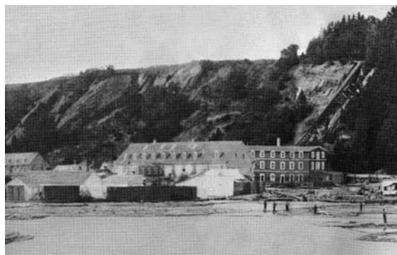
La manufacture de seaux et de manches à balai (à l'avant-plan) est exploitée par George Benson Hall. Cet imposant bâtiment de pierre sera ensuite recyclé en première centrale hydroélectrique. À l'arrière-plan, un édifice de trois étages abrite le moulin Jaune et une autre manufacture. Dans l'escarpement, une conduite forcée est installée à l'emplacement de la Petite Chute. Détail d'une photo de Louis Prudent Vallée vers 1875. Bibliothèque et Archives nationales du Québec, Centre d'archives de Québec, P1000, S4, D26-1, P2
