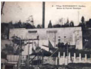
La deuxième centrale hydroélectrique de Montmorency en 1929. Elle est construite au nord-est de la première. L'agrandissement de 1900 constitue l'extrémité ouest du bâtiment. Archives de la Société d'art et d'histoire de Beauport
