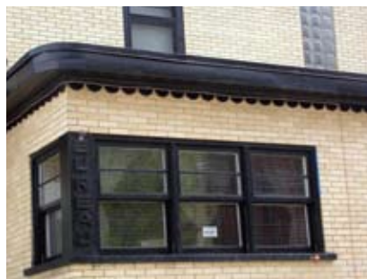
119, avenue Ruel. Le modernisme de ce bâtiment typique des années 1950 contraste avec le caractère plus ancien des immeubles voisins. Photo: Les Alliés, 2010
