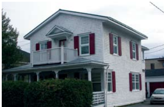
488, 113 e Rue. Comme la plupart des bâtiments en bordure de la voie ferrée, la façade de cette maison, construite en 1927, donne sur la rue perpendiculaire au chemin de fer. Photo: Les Alliés, 2010
