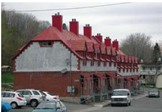
La Coopérative d'habitation Saint-Grégoire, 58-80, boulevard Magella-Laforest. Le « petit bloc », qui portait le même nom, a été rénové et recyclé en 1982-1983. L'immeuble abrite une douzaine de logements. Photo: Les Alliés, 2010
