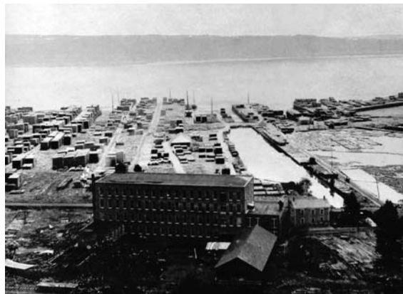
La filature construite et dirigée par Whitehead, vers 1890. Sur les quais, on continue à empiler le bois scié dans les moulins voisins, de moins en moins productifs. Bibliothèque et Archives nationales du Québec, Centre d'archives de Québec, P1000, S4, D26, P12
