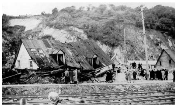
L'éboulis de 1938 . À gauche, la maison double, trop endommagée, devra être démolie. Des gens se tiennent à droite, à l'emplacement de l'immeuble de huit logements, complètement détruit. Collection Marie-Laure Caron-Gagné
