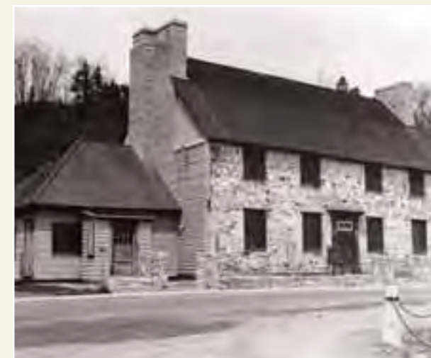
La Maison des Jésuites de Sillery en 1950. Photo : Gérard Morisset. Archives de la Maison des Jésuites de Sillery.
