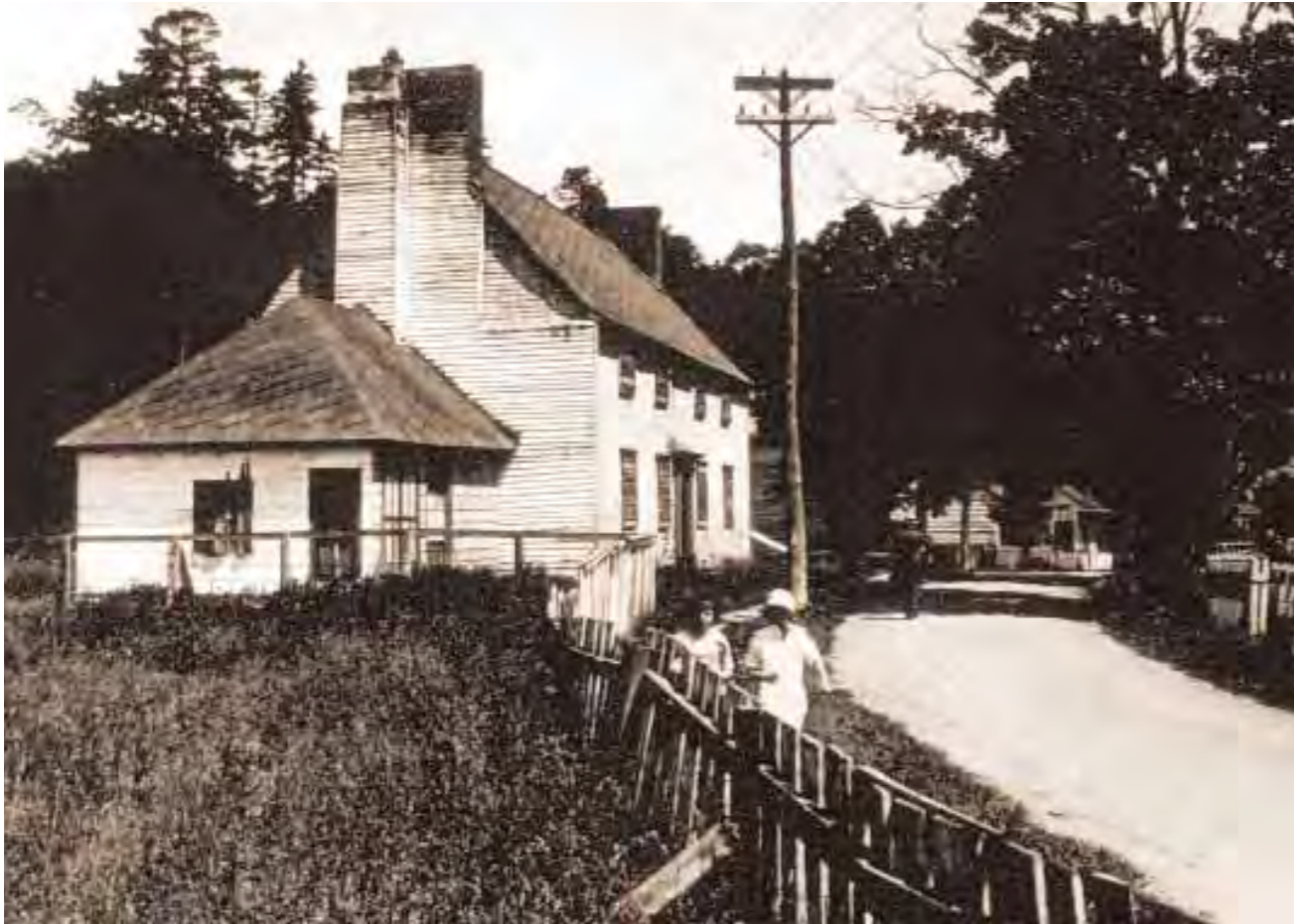
La Maison des Jésuites de Sillery.
