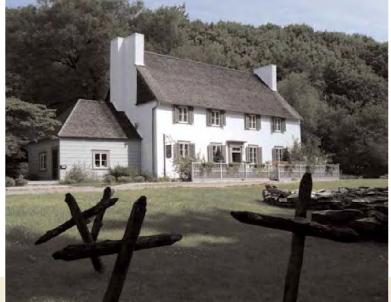
La Maison des Jésuites de Sillery.
