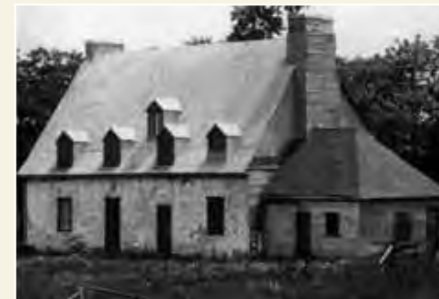
La Maison des Jésuites de Sillery, vue arrière, en 1927. Photo Edgar Gariépy. Archives de la Maison des Jésuites de Sillery. Source : Ville de Montréal, fonds Edgar Gariépy.
