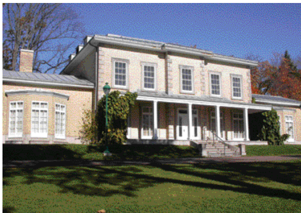
La villa Catacaqui, 2141, chemin Saint-Louis. Photo: Les Alliés, 2007
