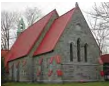
L'église anglicane Saint Michael, 1800, chemin Saint-Louis. Photo: Les Alliés, 2008.
