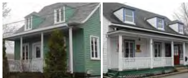
2010 et 2011, rue Narcisse-Roy. Ces maisons en vis-à-vis ont été construites par la famille Roy. Narcisse, le premier sacristain de la paroisse, habitait au 2011. Photos : Les Alliés, 2008.
