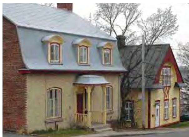
1740 et 1746, côte de Sillery. Plus que centenaires, Cliff Cottage et la pittoresque maison au tournant de la côte semblent défier le temps qui passe. Photos : Les Alliés, 2008.
