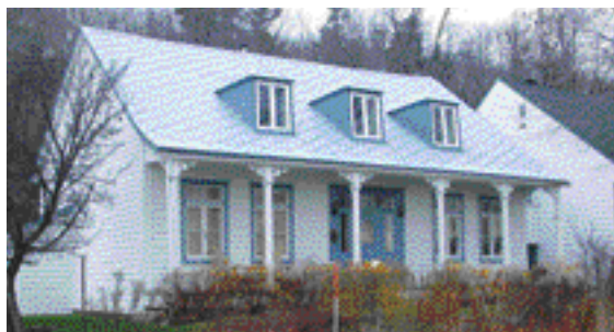
2200, chemin du Foulon. Cette maison se distingue par ses dimensions et la qualité de son ornementation. La première moitié du XIX e siècle se caractérise par le néoclassicisme qui se traduit notamment par la régularité des ouvertures distribuées symétriquement à partir d'un axe central. Photo : Les Alliés, 2006.
