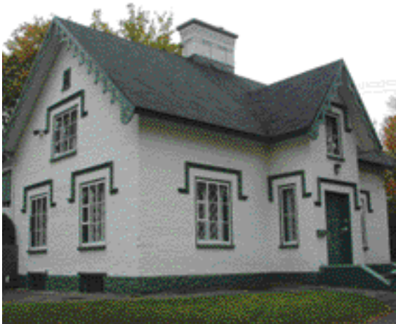
Le pavillon de l'entrée principale du cimetière Mount Hermon, 1801, chemin Saint-Louis. Dessiné par l'architecte Edward Staveley en 1848, le pavillon comporte des rives festonnées aux pignons, une cheminée soigneusement ouvragée et des moulurations agrémentant le haut des ouvertures. Son revêtement initial, en planches de bois, a été remplacé par de la brique. Photo : Les Alliés, 2003.
