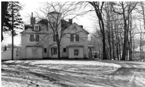
Spencer Grange, façade principale avant la construction de résidences sur l'avenue James-LeMoine. Archives de la Ville de Québec (ancienne Ville de Sillery, 7163).
