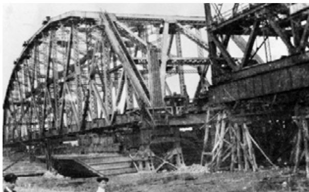
La travée centrale du pont de Québec en construction. Archives de la Ville de Québec (ancienne Ville de Sillery, 11486).
