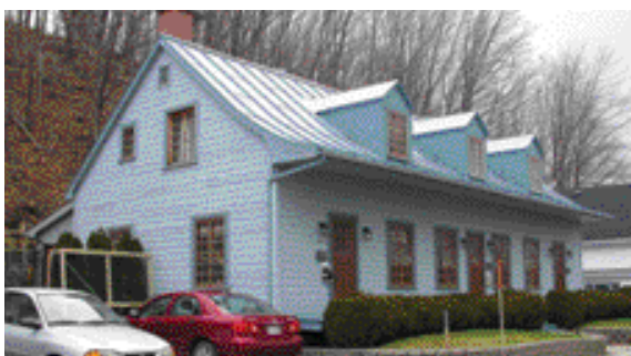
2280-2284, chemin du Foulon. L'unité formelle confère un caractère imposant à cet ensemble composé de trois maisons mitoyennes. Photo : Les Alliés, 2006.
