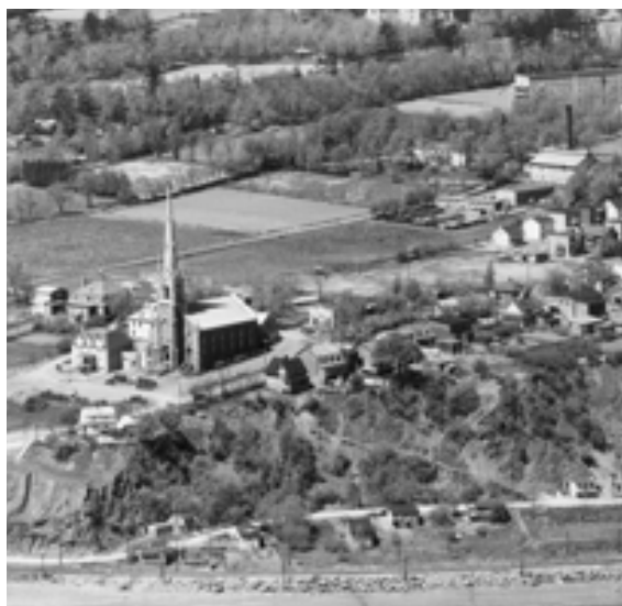
Vue aérienne de la pointe à Puiseaux, vers 1937. Collection privée.
