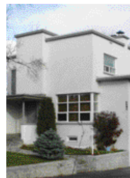
La maison Kerhulu. Photo: Les Alliés, 2006.
