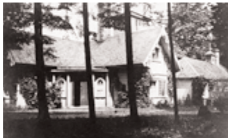
Vue de Bagatelle au début des années 1920. À l'angle de deux ailes, le porche, qui s'ouvre sur la salle à manger (à droite) et le boudoir (à gauche), est orné de colonnes engagées flanquant les fenêtres ogives. Fondation Bagatelle.
