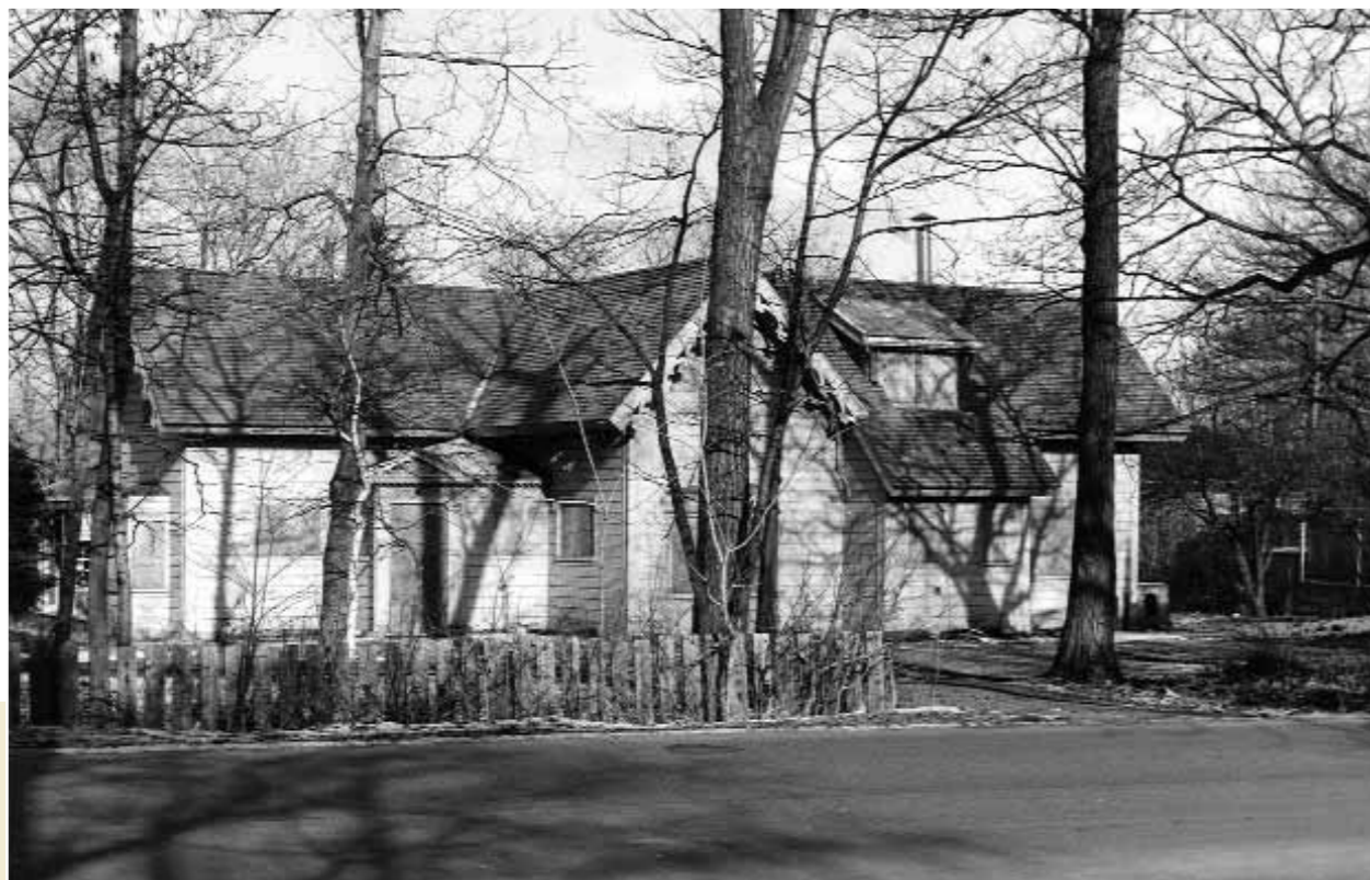
Bagatelle pendant la longue période d'abandon. Les ouvertures sont obstruées par du contreplaqué. Archives de la Maison des Jésuites de Sillery.
