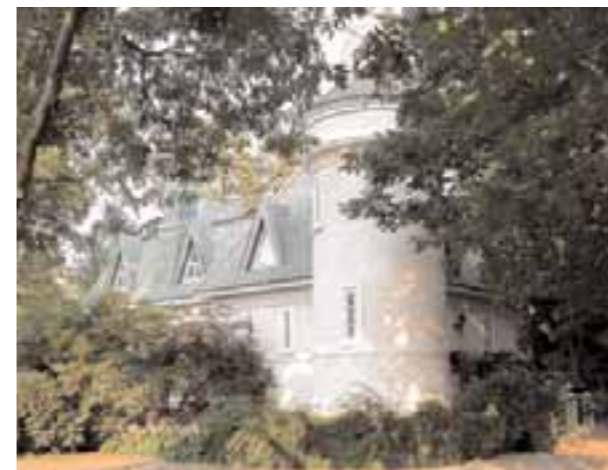
L'ancienne maison du gardien du Bois-de-Coulonge, dessinée par l'architecte Eugène-Étienne Taché en 1891. Photo: Les Alliés, 2007.
