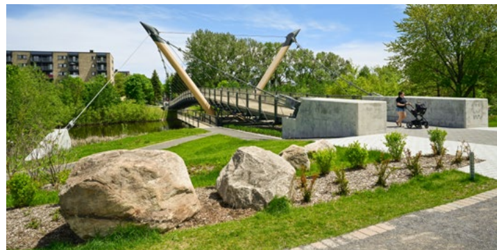
La passerelle de la Tortue enjambant la rivière Saint-Charles permet de franchir une contrainte naturelle et de relier le quartier Saint-Roch à Limoilou.
