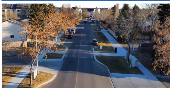
Avancée de trottoirs combinée à une traverse piétonne surélevée (Edmonton)
