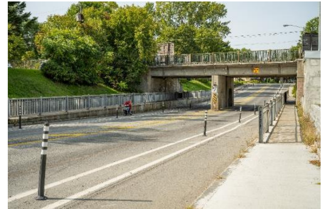
Passage sous les viaducs – situation actuelle non sécuritaire
