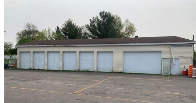
Garage à régulariser
