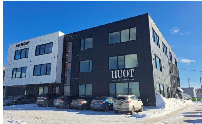
Exemple lot à vocation non souhaitée dans un parc industriel
