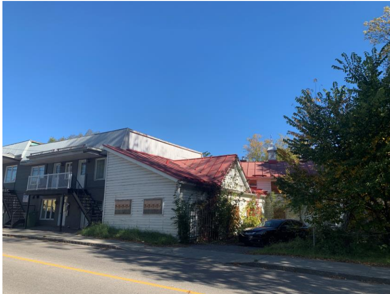
Bâtiment condamné donnant sur le boulevard Masson à démolir
