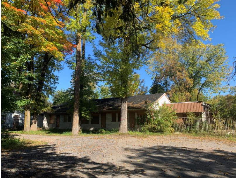
Bâtiment incendié à démolir
