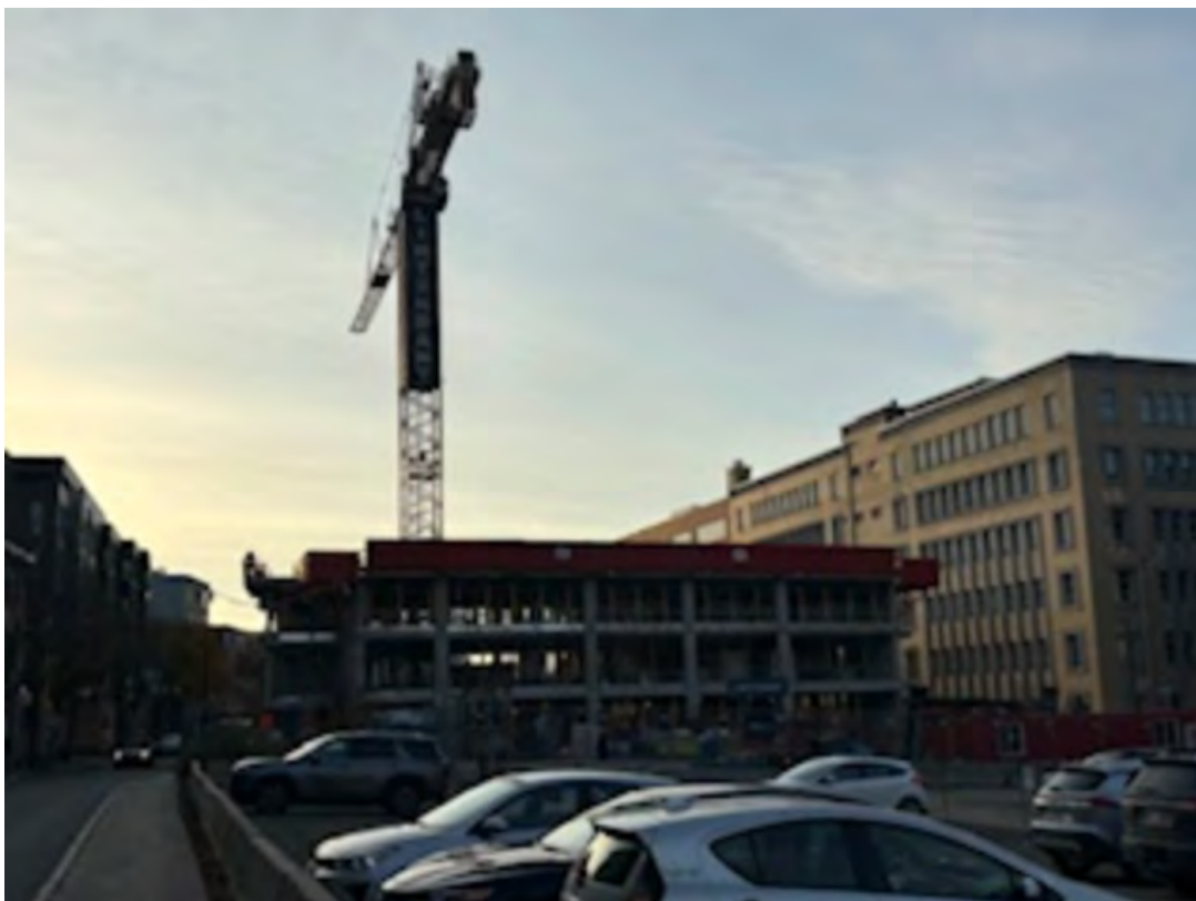
L'Intendant sur Saint-Vallier Est, en construction
