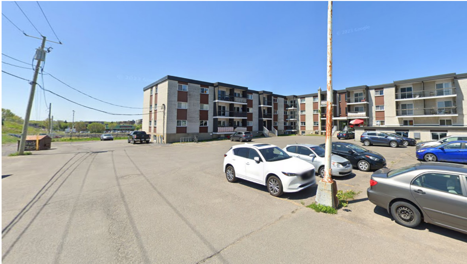
Vue sur la cours intérieure.
