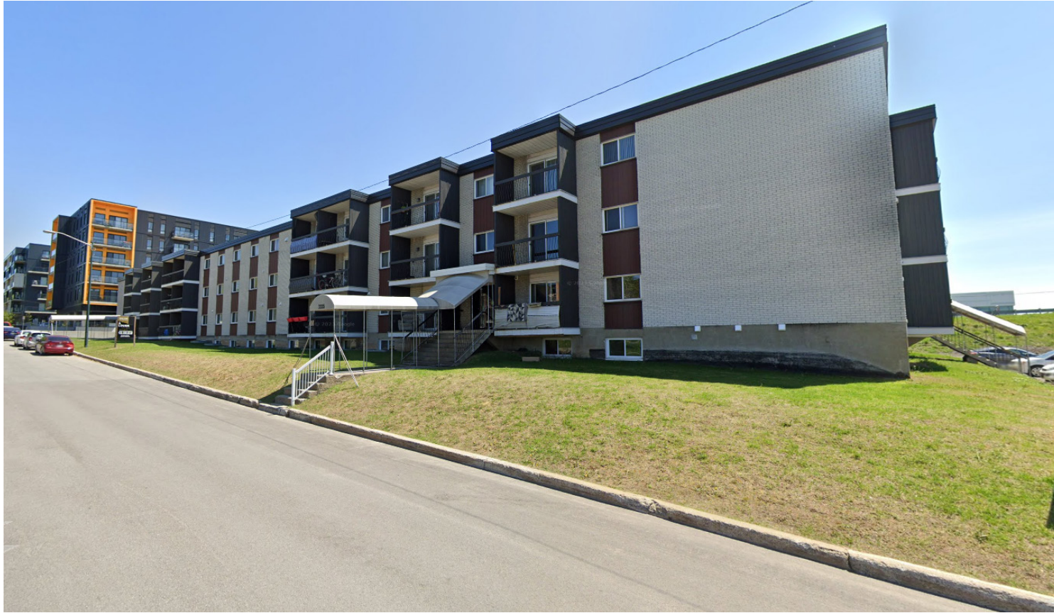
Façade principale du bâtiment existant.
