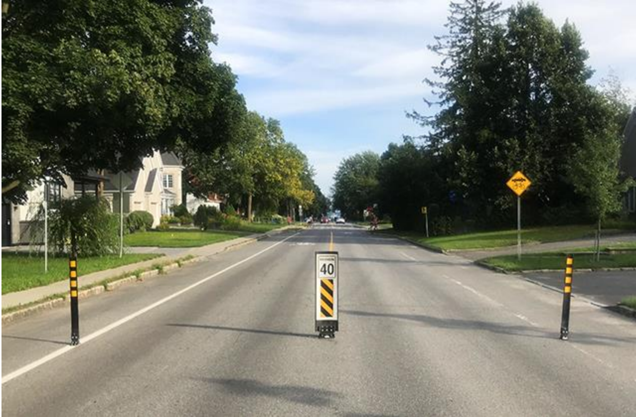
Exemple de balise portique à Québec
