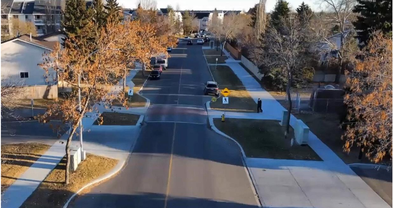
Avancée de trottoirs combinée à une traverse piétonne surélevée Source : Ville d'Edmonton
