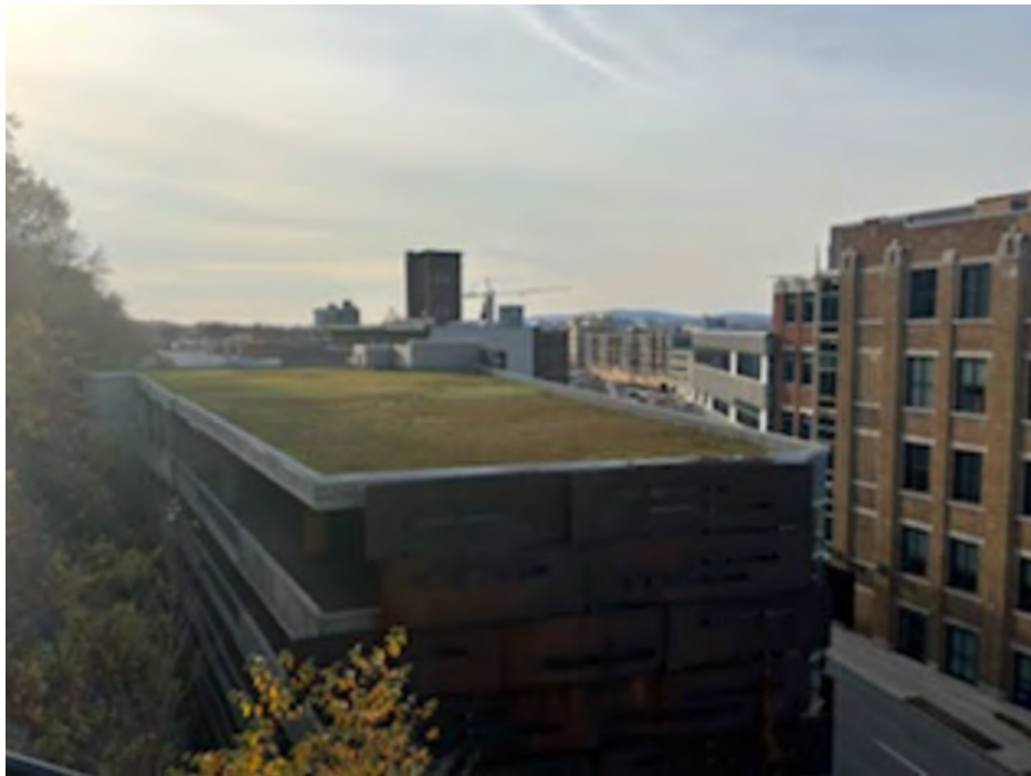
Vue de la placette éventuellement bouchée par l'hôtel
