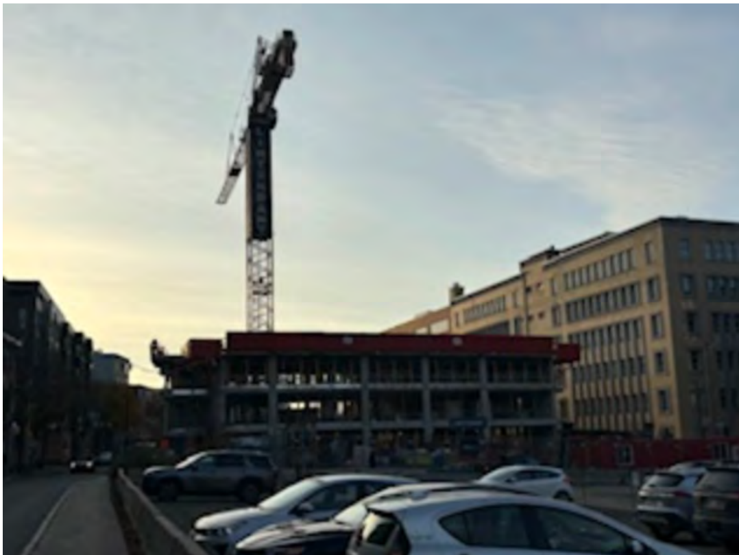
L'Intendant sur Saint-Vallier Est, en construction
