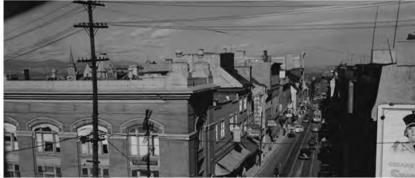
Description : Construction partielle du lot 3004 – (lot 3003 – voir enseigne verticale). (source : Carpentier 1948 – rue Saint-Jean)
