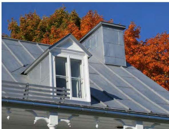
Figure 14. La toiture de tôle à baguettes de la maison Tessier-dit-Laplante au 2328, avenue Royale. IMG\_0569.jpg
