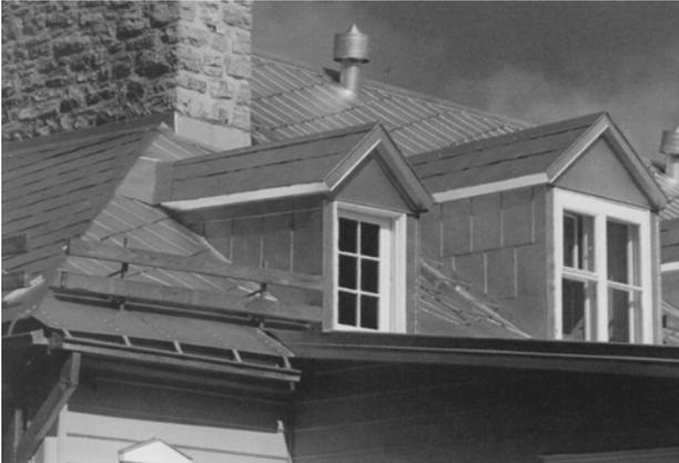
41. Couverture en tôle «à la canadienne» avec barrière à neige et ventilateurs de toit.
