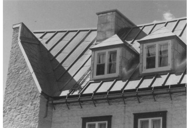
42. Couverture « à baguettes » avec gouttière et supports en tôle galvanisée.
