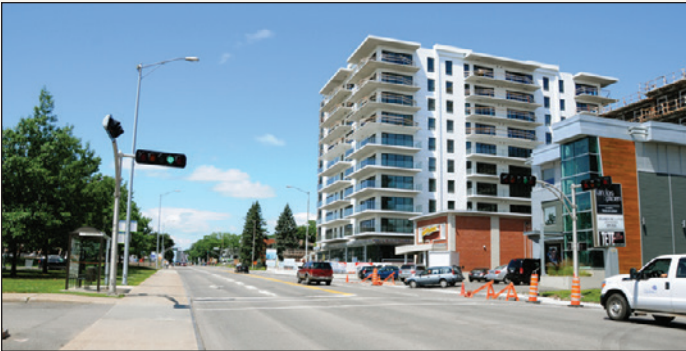
Redéveloppement en cours sur la route de l'Église
