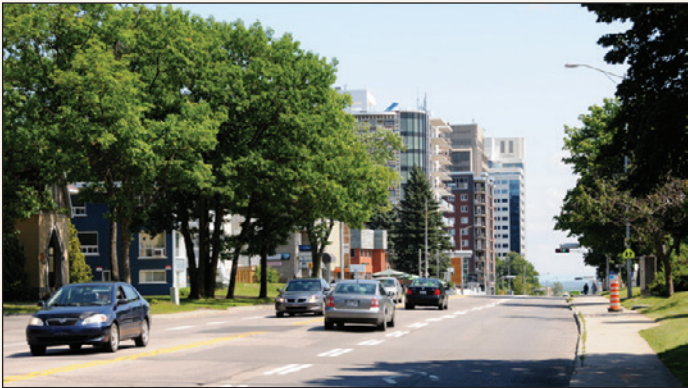
Route de l'Église, vue en direction sud
