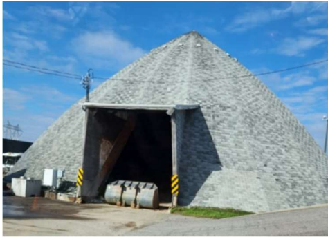
Photo 2 – Entrepôt avec surplomb à l'entrée
